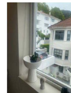
Vindu fra 1988, skiftet pakninger på alle vinduer i 2020
