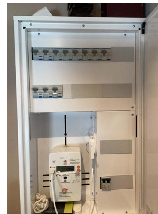
Skjema: "951 - NELFO Per. kontr. Bolig S1 NEK405-2" Spørsmål: Utstyrets kapslingsgrad Beskrivelse: Tavle 2etg, Filnavn: img_0001.jpg
