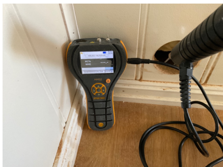
Fuktmåling i vegg ved hulltaking.
