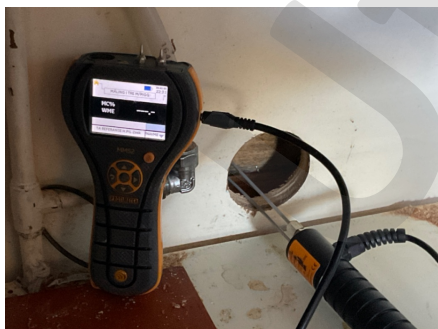
Fuktmåling i vegg ved hulltaking.
