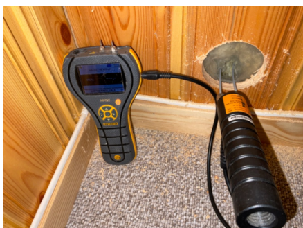
Fuktmåling i vegg ved hulltaking.
