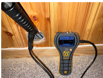
Fuktmåling i utforet kjellervegg
