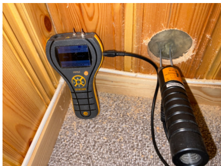
Fuktmåling i vegg ved hulltaking.
