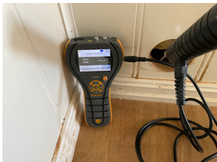
Fuktmåling i vegg ved hulltaking.
