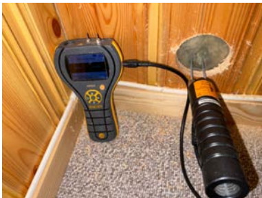
Fuktmåling i vegg ved hulltaking.
