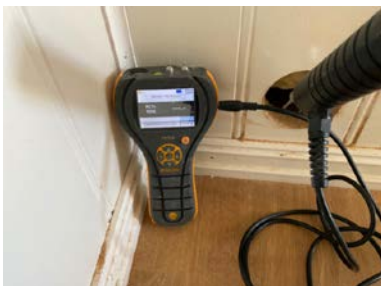
Fuktmåling i vegg ved hulltaking.
