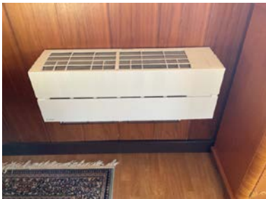
Luft til luft varmepumpe.
