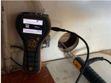
Fuktmåling i vegg ved hulltaking.
