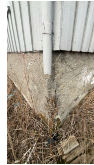
Manglefull bortledning av vann fra grunnmur.
