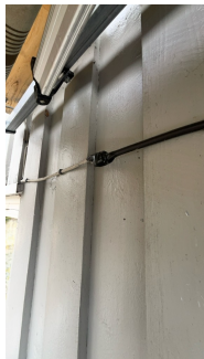
Ufagmessig utførelse av utvendig kobling.
