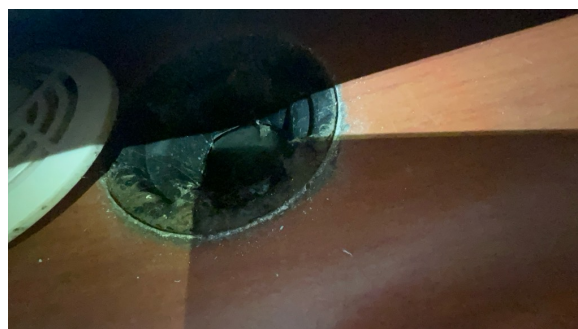
Kontroll av sluk.
