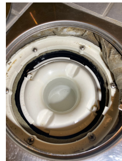
Sluk med synlig mansjett og klemring.
