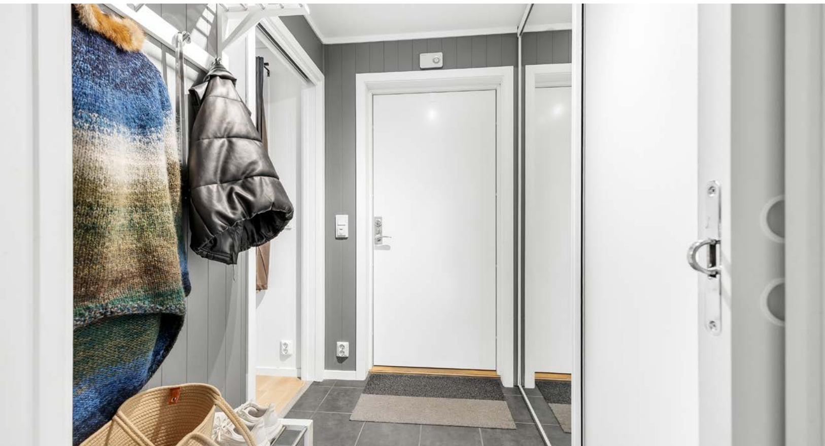
Det er lun gulvvarme under det flislagte gulvet.
