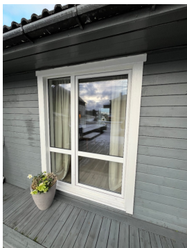
TG 1 Balkonger, terrasser og rom under balkonger
