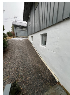
Del av bolig med isolasjon og grunnmurs plast utvendig.
