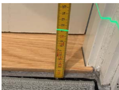
Fallforhold ca. 110 mm overkant gulv ved terskel
