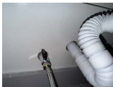
Rørgjennomføring bak servantinnredning
