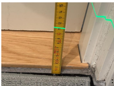
Fallforhold ca. 110 mm overkant gulv ved terskel
