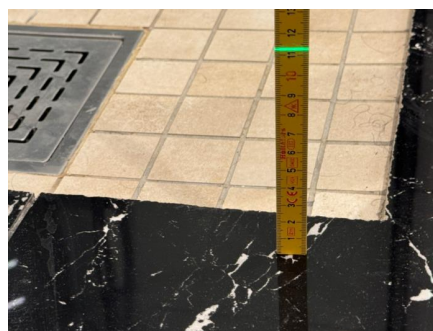
Fallforhold ca. 112 mm overkant gulv ved dusjsone
