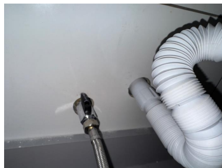
Rørgjennomføring bak servanttinnredning
