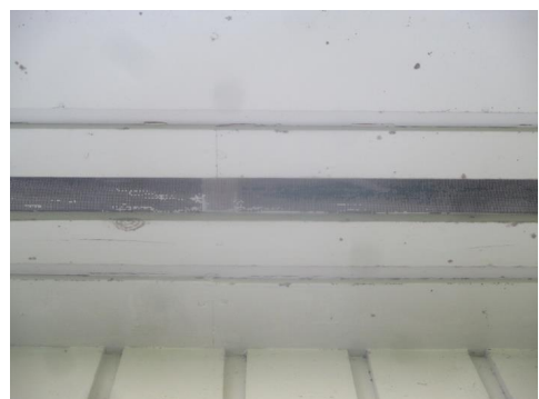
Bra med luftespalter i gesimsen for tilgang på luft til kaldtloftet.
