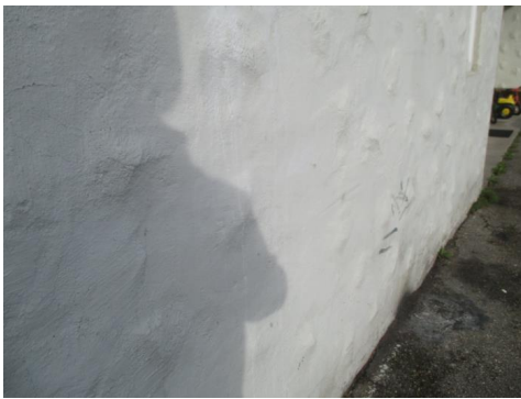
Deler av grunnmur.
