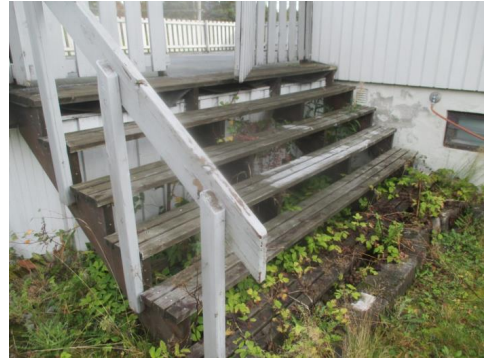
Trapp til terrasse over garasje.
