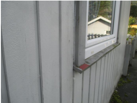
Deler av kledningen med tilhørende belistninger.
