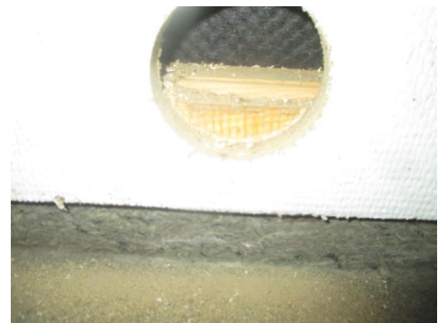
Hulltaking i utfored vegg på vaskerommet.
