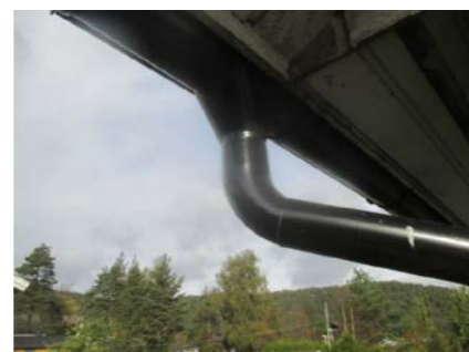
Deler av takrenner og nedløp.
