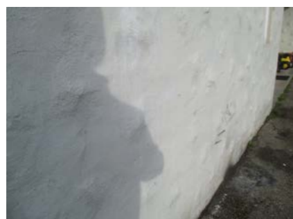
Deler av grunnmur.
