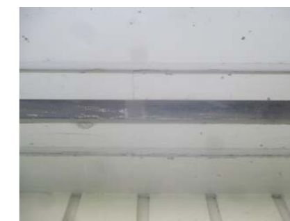
Bra med luftespalter i gesimsen for tilgang på luft til kaldtloftet.
