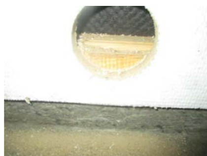
Hulltaking i utfored vegg på vaskerommet.
