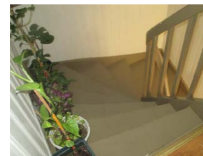
Trapp i mellom etasjer.
