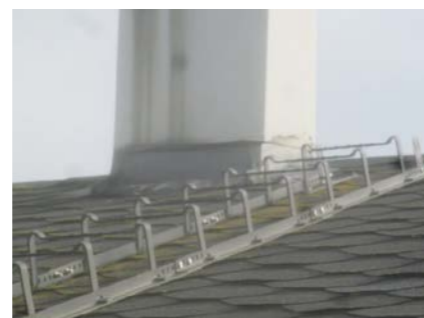
Noe eldre taktekking av shingel.
