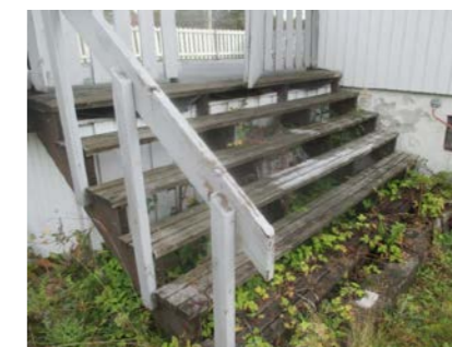
Trapp til terrasse over garasje.
