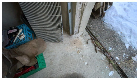
Deler av mur mot port er ikke pusset
