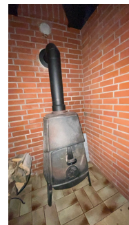
Vedovn i underetasje, det er montert varmekremlings vifte opp til 1. etasje i etasjeskiller. Det bør monteres pakning på dør.
