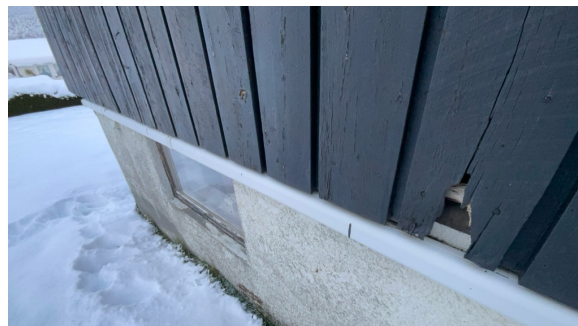
Synlig råte i enkelte bord på gavelvegg
