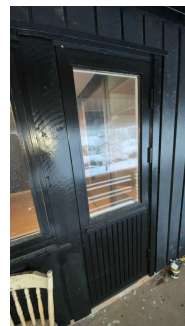
Balkongdør fra soverom fra byggeår. Døra er vanskelig å lukke gunnet feil justering
