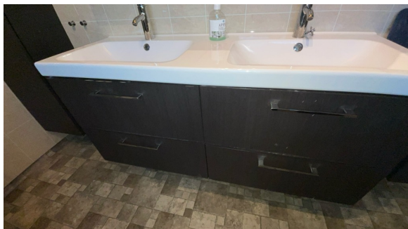
Synlig slipp av folie på innredning
