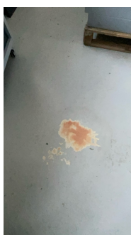
Det er noe misfarging av maling på gulv.
