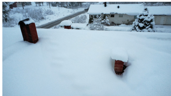
Pipehatt og luftehatt
