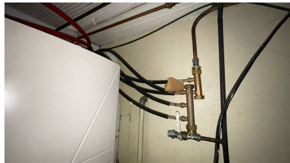
Vannfordeling til bad underetasje. Kurser merket. Kan med fordel merkes på egen kursplansje.
