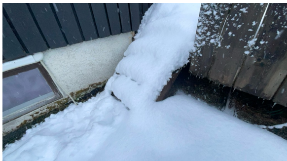
Trapp i tre fra hage til veranda
