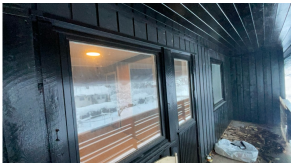
Vindu på soverom
