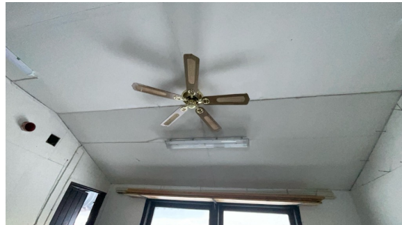
Overganger i himling er ikke sparklet ferdig mellom flat og skrå himling
