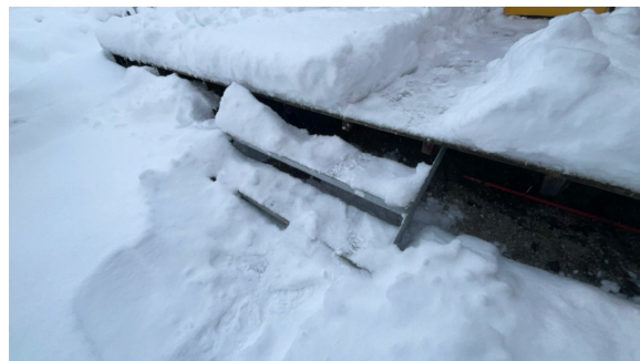
Trapp i strekkmetall ved inngang til 1. etasje
