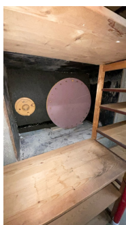
Inspeksjonsluka til tank sett fra lagerrom. Planlagt brukt til oppvarming av varmtvann
