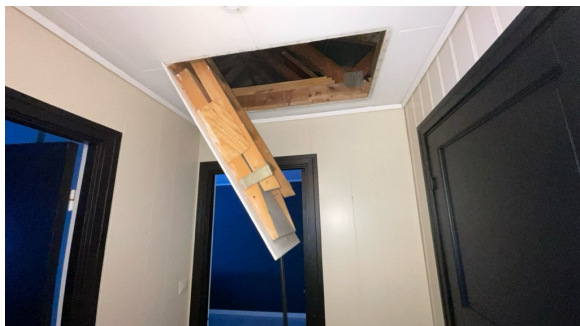
Uisolert loftsluke med stige i gang
