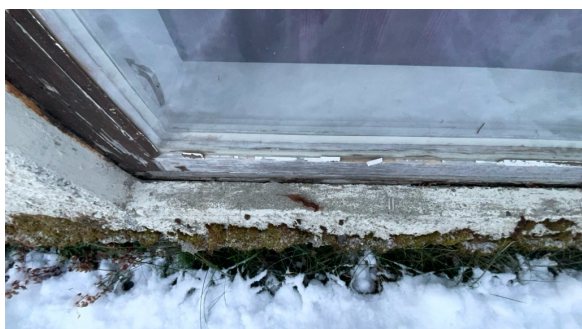
Vinduer som er montert i mur mangler beslag og kan ha skjulte skader med råte bak puss
