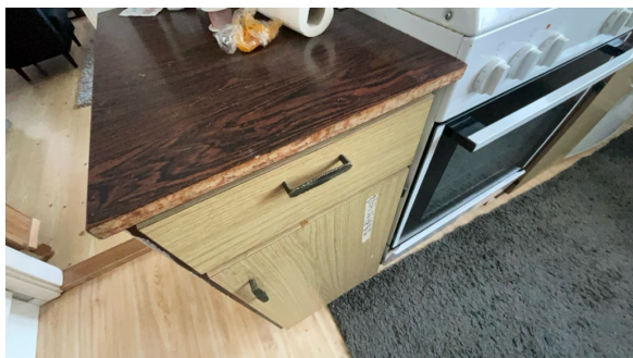
Kantlist mangler på benkeplater ved komfyr
