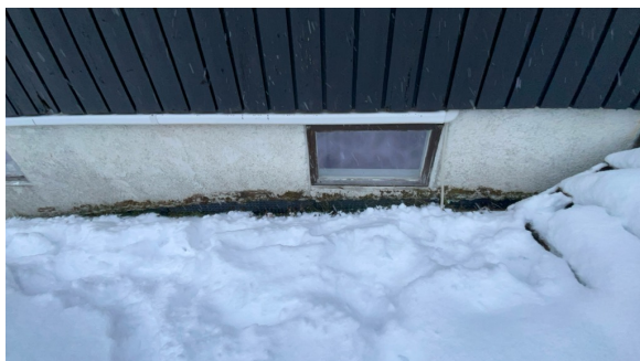
Synlig grunnmursplast langs grunnmur
