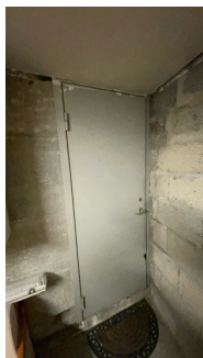
Dør til teknisk rom sett fra lagerrom. Døra tar i karm
