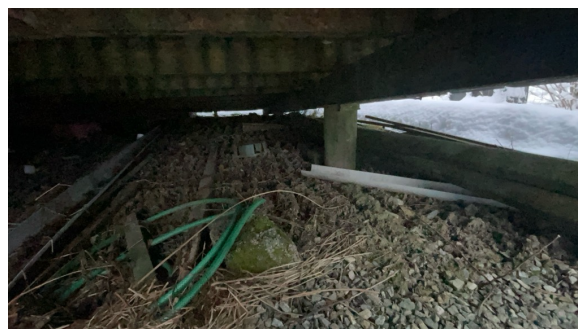
Veranda er opplagret på påler av tre
