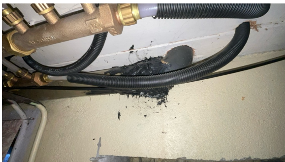
Rør i teknisk rom har vært utbedret med fugemasse
