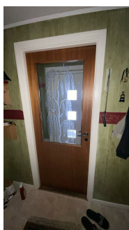
Dør til teknisk rom sett fra lagerrom. Døra tar i karm
