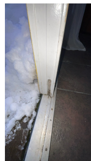
Mangler låsing på dobbeltdør mot terskel. Den bør monteres for å sikre tilstrekkelig tetthet.
