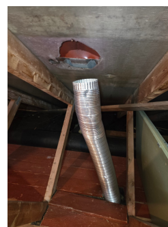
Avtrekksrør er ikke ført tilstrekkelig opp i avtrekkshette på tak og mangler isolering
