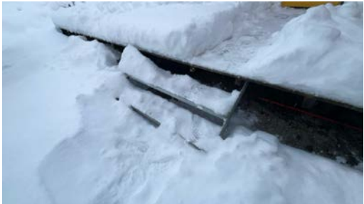
Trapp i strekkmøtall ved inngang til 1. etasje
