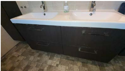
Synlig slipp av folie på innredning
