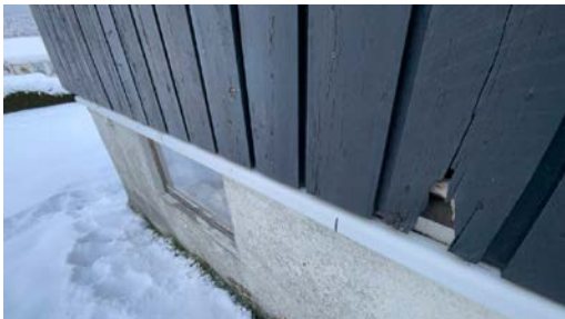
Synlig råte i enkelte bord på gavelvegg
