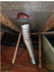
Avtrekksrør er ikke ført tilstrekkelig opp i avtrekksnette på tak og mangler isolering
