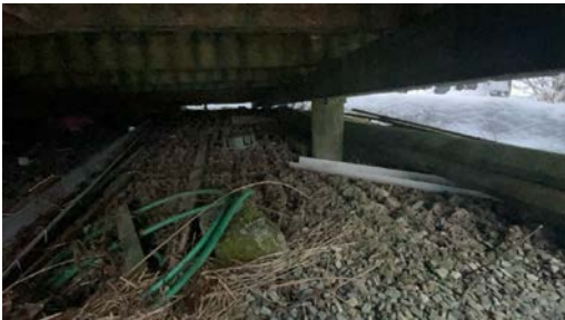
Veranda er opplagret på påler av tre
