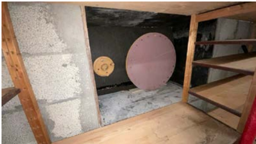
Åpning mot tank er tilgjengelig fra lagerrom. Tank er ikke kontrollert
