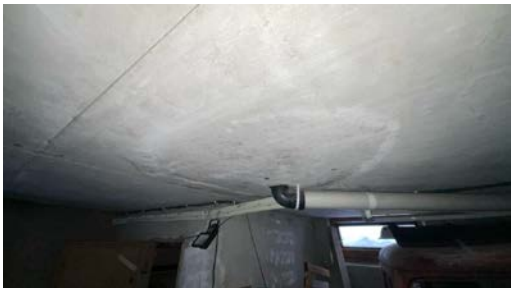
Synlig eldre fuktsvelling i brannsikre plate ved rørgjennomføring til sluk
