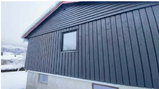
Gavelvegg med behov for utbedring
