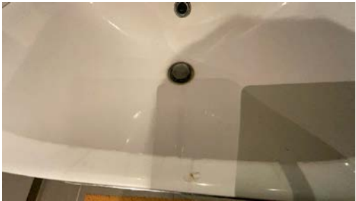
Skade i servant, tettet med fugemasse
