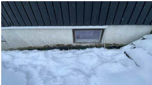
Synlig grunnmursplast langs grunnmur
