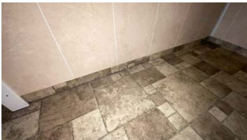
Belegg mot skillevegg er ikke tett. Veggen er nok satt opp på gulvet. Anbefaler å få sveiset/fuget overgang gulv og vegg.
