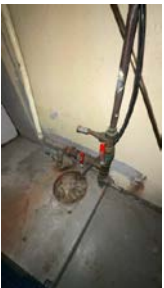
Hovedstoppekrane og egen stoppekrane på utekrane med drenering
