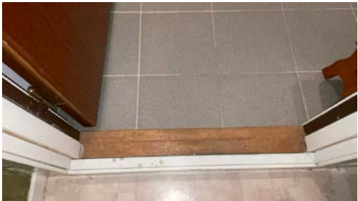
Standard dørterskel uten tilluft
