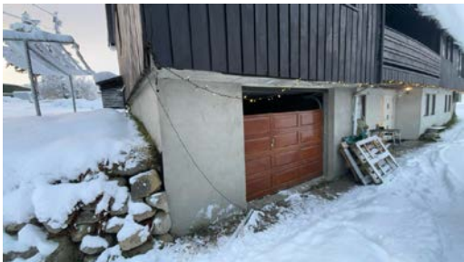
Oversikt, synlig at port element ikke er montert
