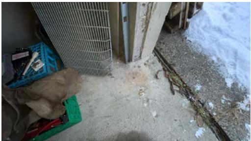
Deler av mur mot port er ikke pusset
