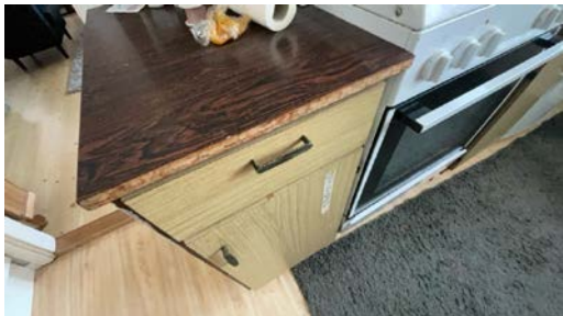
Kantlist mangler på benkeplater ved komfyr
