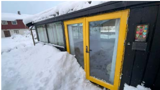
Hoveddør fra 2016. Mangler låsing på dobbeltdør mot terskel. Den bør monteres for å sikre tilstrekkelig tetthet.
