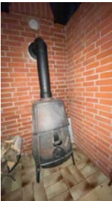
Vedovn i underetasje, det er montert varmfordelings vifte opp til 1. etasje i etasjeskiller. Det bør monteres pakning på dør.
