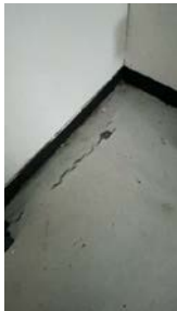
Det er noe avskalling av maling på gulv.
