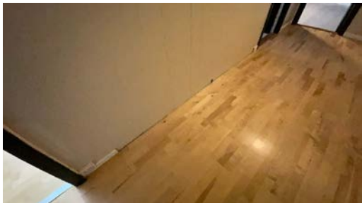
Mangler deler av gulvlist i gang 1. etasje, noe knirk og bevegelse i gulvet.
