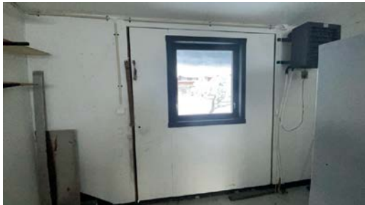
Deler av vegg/dør som tas ut for tilkomst fra utsiden er ikke tett
