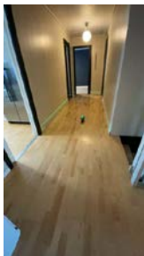
1. etasje Plassering av laser ved kontroll av gang. Det er målt 8 mm høydeforskjell gjennom rommet. TG 1.
