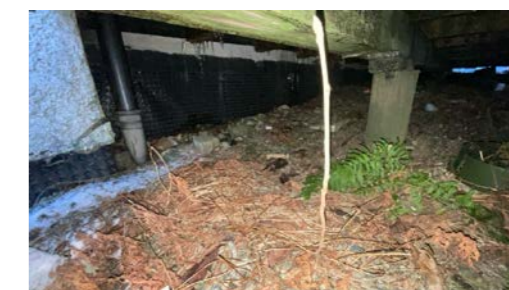
Synlig grunnmursplast under veranda mot krypkjeller og ståltank
