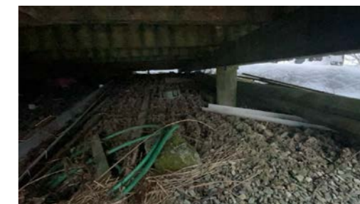
Veranda er opplagret på påler av tre
