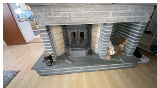
Integrert peis i pipe i underetasjen
