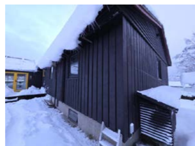
Synlig råte i enkelte bord på gavelvegg
