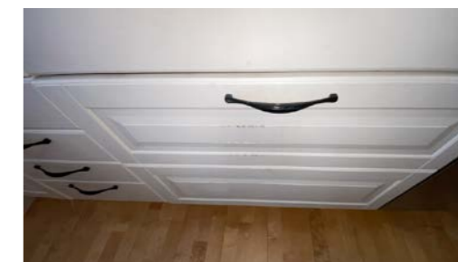
Svelling/skade på kjøkkenfront under vask
