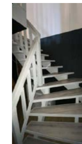
Trapp sett fra kjeller/underetasje
