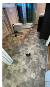
Oversikt gulv, høyde er målt fra skyvedør til garderobe. Belegg ved dør er ført opp på dørterskel.
