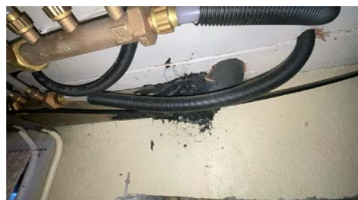
Rør i teknisk rom har vært utbedret med fugemasse
