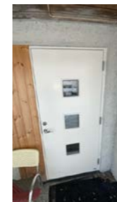
Malt Nordan dør til leilighet i underetasjen med 3-lags glass fra 2020. Sprekk i ett innvendig glass på dør i underetasjen Sprekk i ett glass på innsiden.
