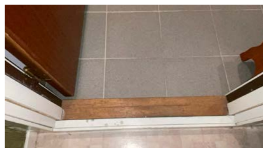
Standard dørterskel uten tilluft
