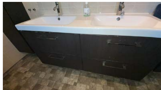
Synlig slipp av folie på innredning
