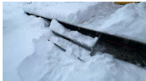
Trapp i strekkmetall ved inngang til 1. etasje
