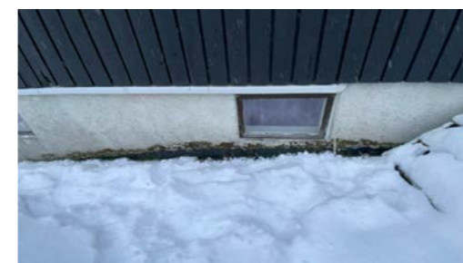
Synlig grunnmursplast langs grunnmur
