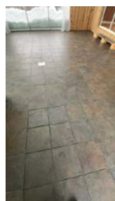
Store deler av flis gulvet er løse og skadet
