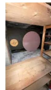
Inspeksjonsluke til tank sett fra lagerrom. Planlagt brukt til oppvarming av varmtvann
