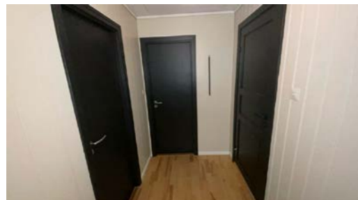
Dører til soverom og bad/vaskerom
