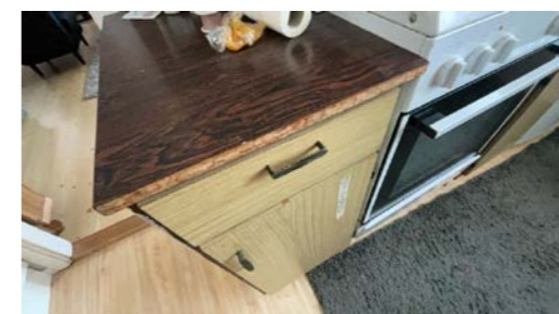
Kantlist mangler på benkeplater ved komfyr
