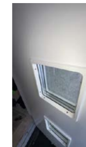
Malt Nordan dør til leilighet i underetasjen med 3-lags glass fra 2020. Sprekk i ett innvendig glass på dør i underetasjen Sprekk i ett glass på innsiden.
