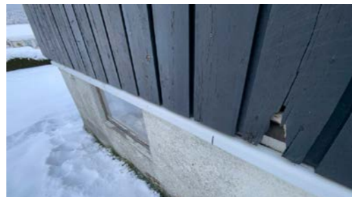
Synlig råte i enkelte bord på gavelvegg
