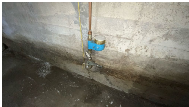
Besiktigelse av røropplegg.
