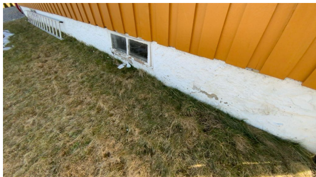
Kontroll av drenering/fuktsikring.
