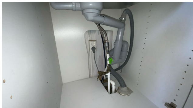
Besiktigelse av røropplegg.
