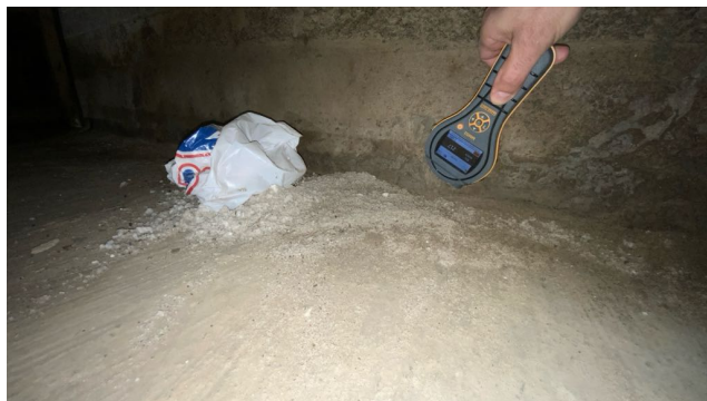
Utført fuktsøk på nedre del av grunnmur.
