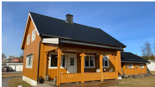
Besiktigelse av taktekke.
