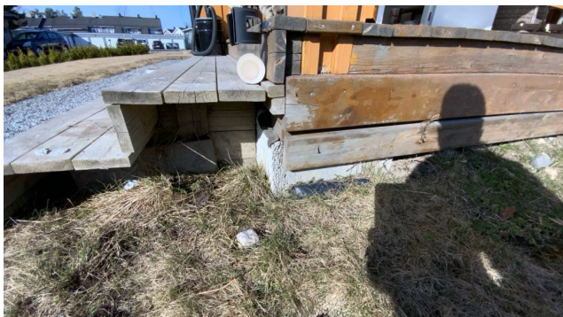
Kontroll av fundament.
