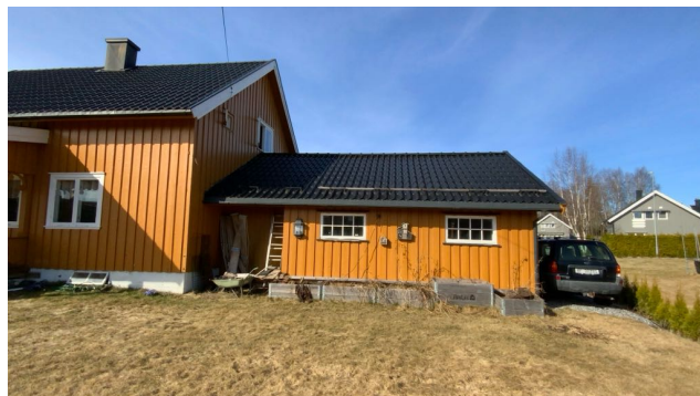
Besiktigelse av taktekke.
