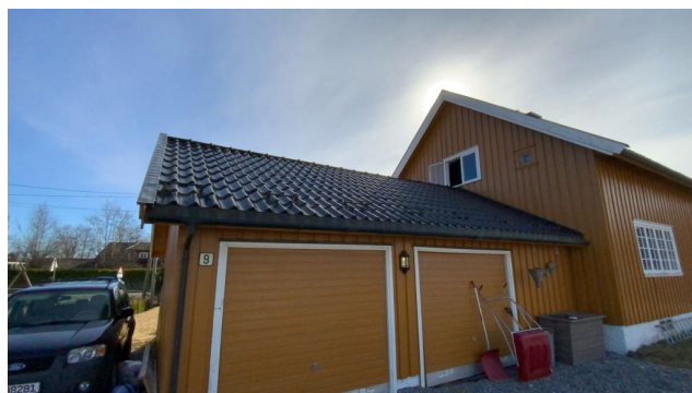
Besiktigelse av taktekke.
