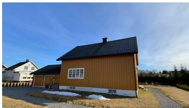
Besiktigelse av taktekke.
