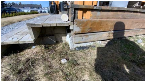
Kontroll av fundament.
