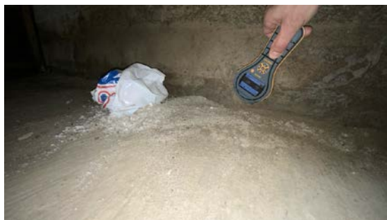
Utført fuktsøk på nedre del av grunnmur.
