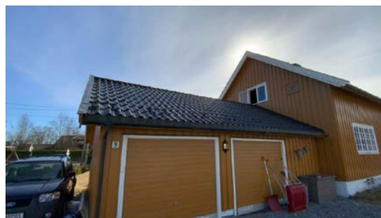
Besiktigelse av taktekke.
