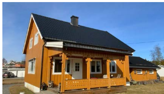
Besiktigelse av taktekke.
