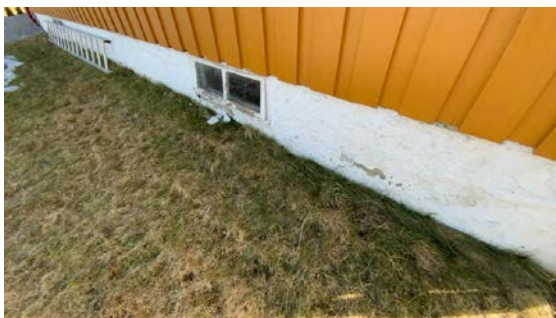
Kontroll av drenering/fuktsikring.
