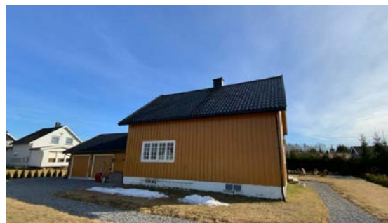
Besiktigelse av taktekke.
