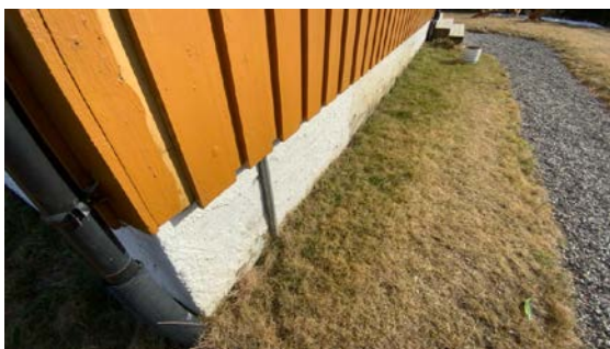
Kontroll av drenering/fuktsikring.
