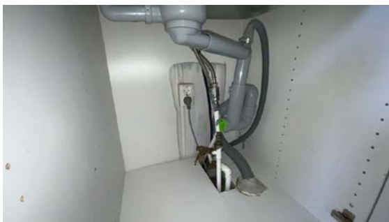
Besiktigelse av røropplegg.
