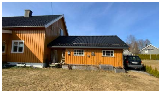
Besiktigelse av taktekke.
