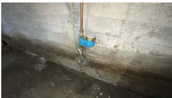
Besiktigelse av røropplegg.
