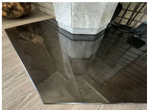
Sprekk i plate under ovn.
