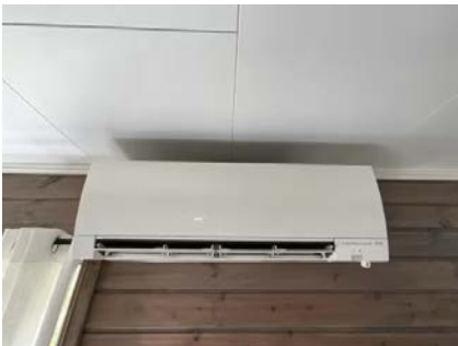
Viser innedel montert i stue.
