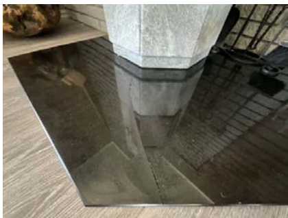
Sprekk i plate under ovn.
