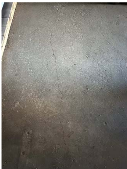
Mindre sprekk som er pusset i mellom tilbygg.
