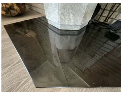
Sprekk i plate under ovn.
