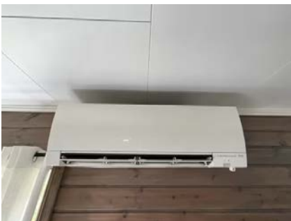
Viser innedel montert i stue.
