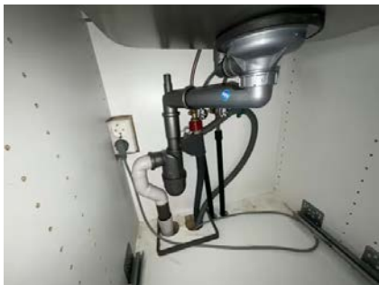
Viser vann og avløpsinnstallasjoner under kum.
