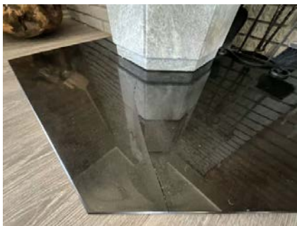
Sprekk i plate under ovn.
