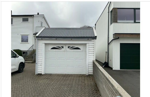
Garasje oppført i trekonstruksjon
