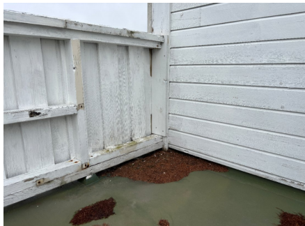
Balkong over inngangspartiet er tekket med sinkbelegg
