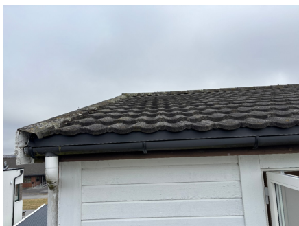
Taket er tekket med stålplater med beleg
