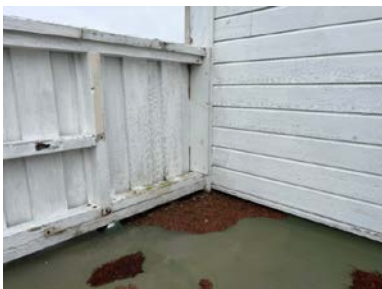
Balkong over inngangspartiet er tekket med sinkbelegg
