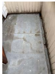
Balkong over stuen er tekket med pvc belegg
