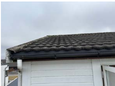
Taket er tekket med stålplater med beleg
