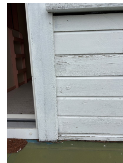
Kledning er avsluttet mot balkongdekke
