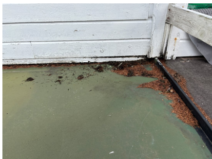
Kledning er avsluttet mot balkongdekke
