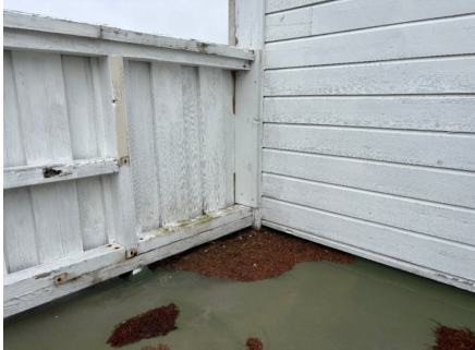
Balkong over inngangspartiet er teknet med sinkbelegg
