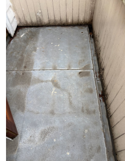
Balkong over stuen er teknet med pvc belegg
