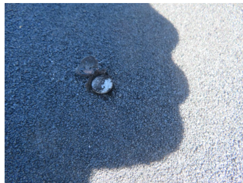
Spiker kommer opp gjennom tekking.
