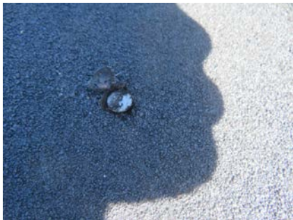
Spiker kommer opp gjennom tekking.
