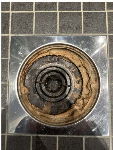
Viser sluk i dusjsonen.
