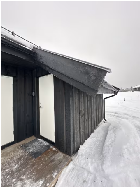
Viser bod med utvendig adkomst.
