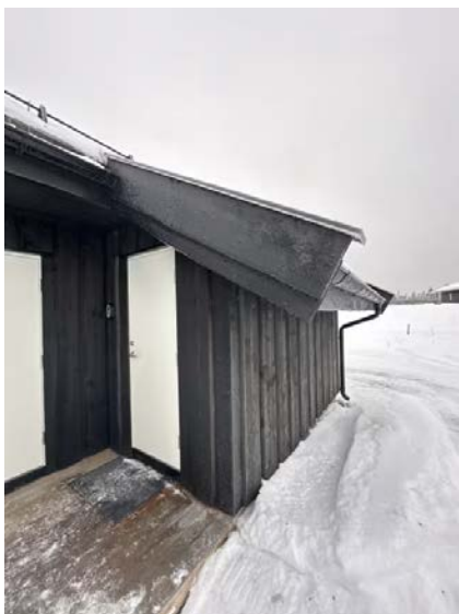
Viser bod med utvendig adkomst.
