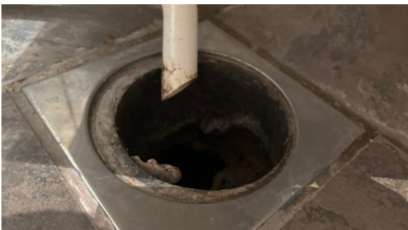
Eldre støpejernssluk
