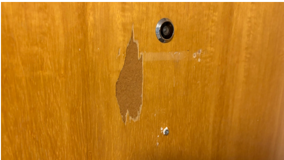
Skade i overflaten på ytterdøren
