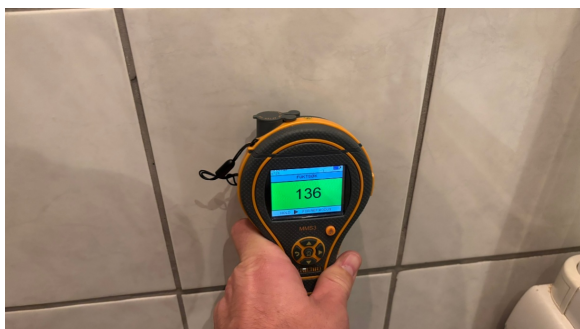
Fuktsøk i overflater
