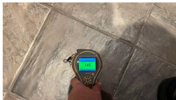
Fuktsøk i overflater
