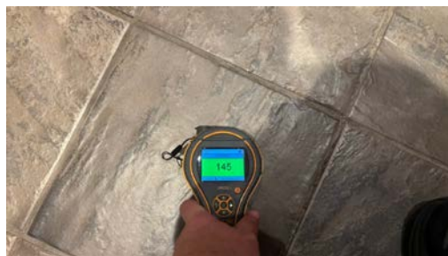
Fuktsøk i overflater
