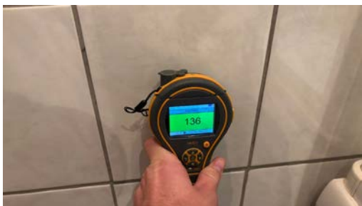
Fuktsøk i overflater
