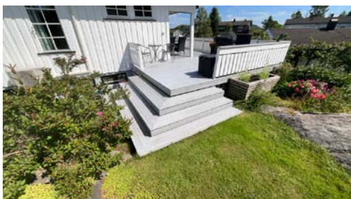
Utvendig trapp i tre.
