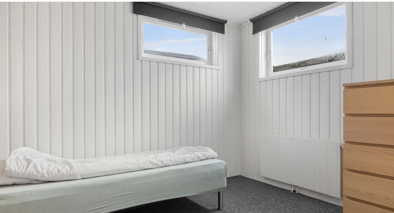
Rom i kjeller innredet som soverom. Rommet er i byggetegninger definert som arbeidsrom og ikke søkt bruksendret. Det er ikke godkjent til varig opphold. Se punktet "Ferdigattest/midlertidig brukstillatelse" i salgsoppgaven.
