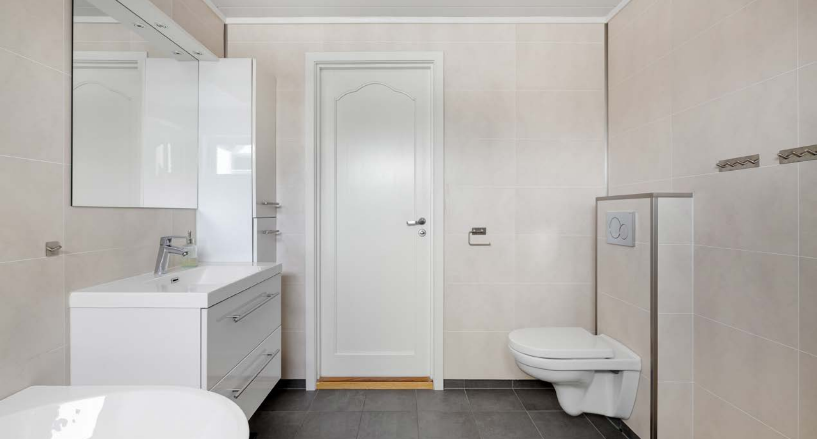
Pent bad i 1. etasje med flislagt gulv med varmekabler og baderomsplater på veggene. I himlingen er det downlights.
