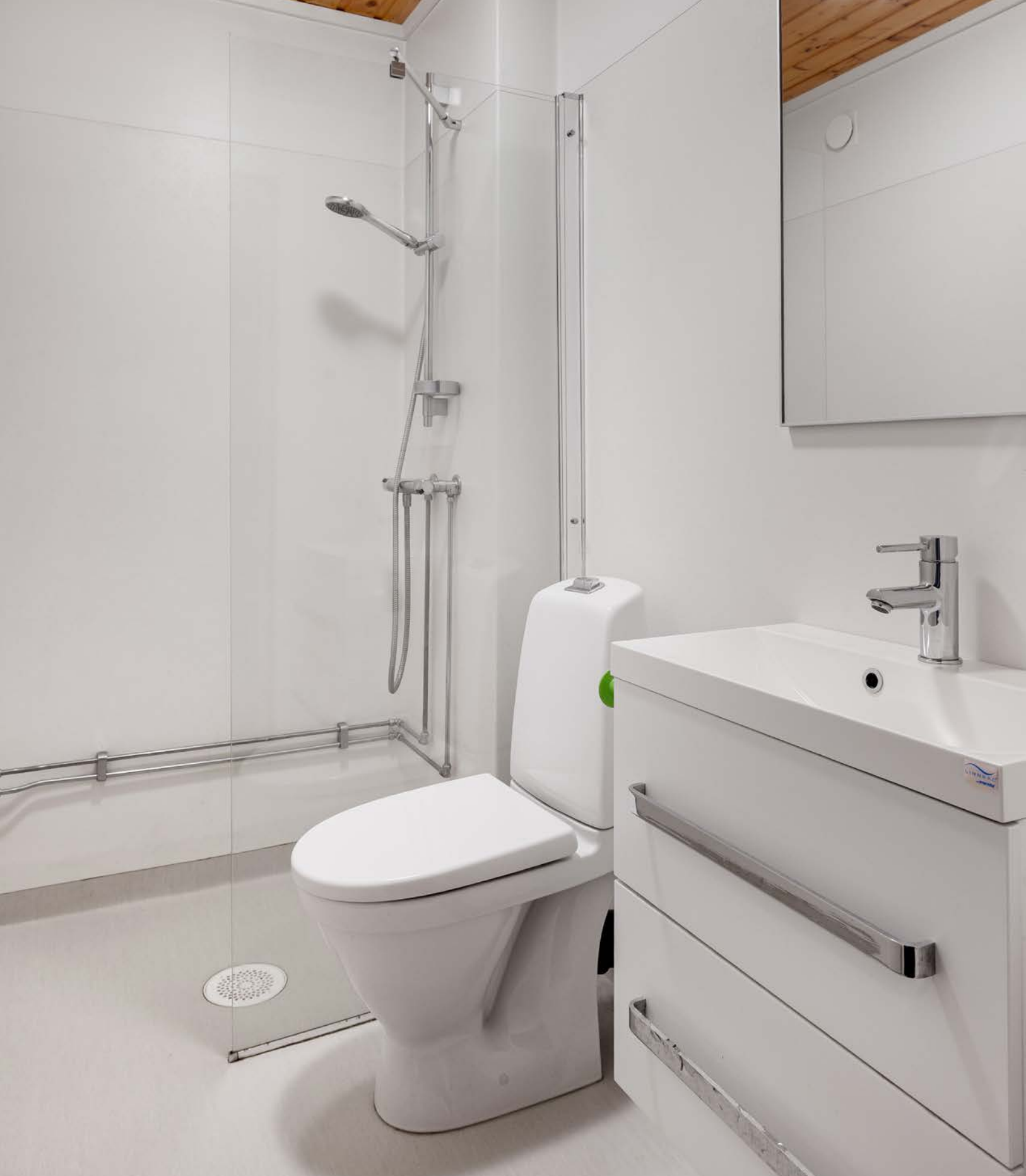
Bad i kjeller med vinylbelegg på gulvet og våtromstapet på veggene. Badet er utstyrt med gulvmontert toalett, baderomsinnredning og dusjnisse med veggmontert dusjbatteri og skillevegg. Innredningen har fått nye knotter etter foto.
