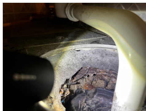
Duk ikke festet under klemring i sluk
