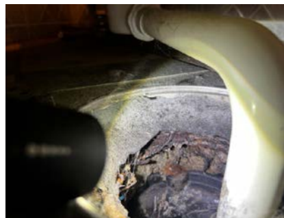
Duk ikke festet under klemring i sluk
