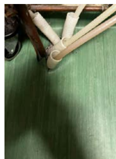
Utette rørgjennomføringer i gulvet
