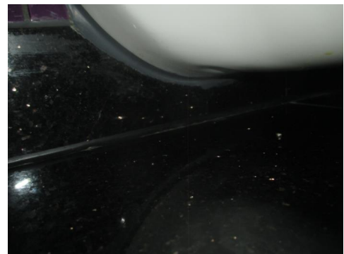
Ingen hull for synliggjøring av lekkasjevann.
