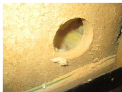
Hulltaking fra kott i fellesgangen.
