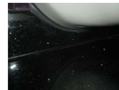
Ingen hull for synliggjøring av lekkasjevann.
