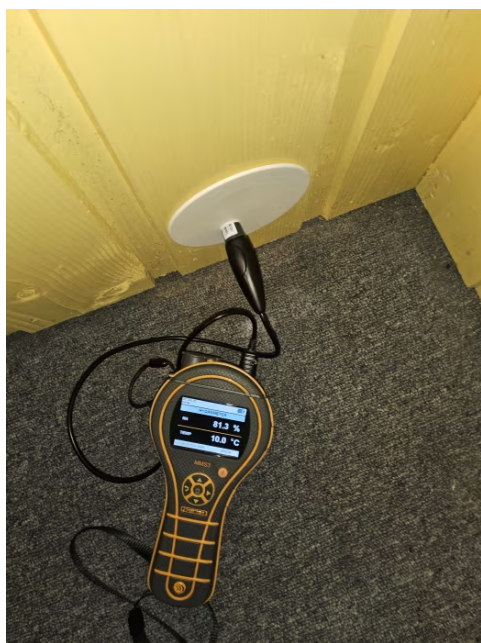
Bilde fra fuktmåling i utlektet veggkonstruksjon.
