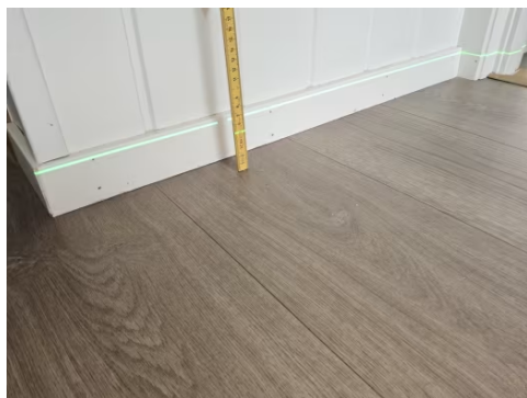
Etasjeskiller er kontrollert med nivelleringslaser.
