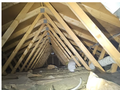
Boligen er oppført med kaldtloft.
