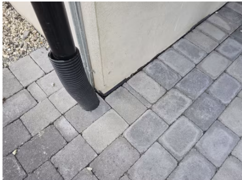
Taknedløp er ført ned drensrør.
