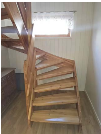
Åpen trapp av tre mellom etasjene.
