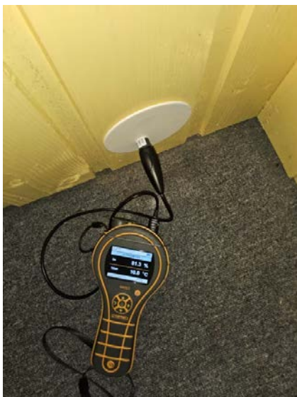
Bilde fra fuktmåling i utlektet veggkonstruksjon.
