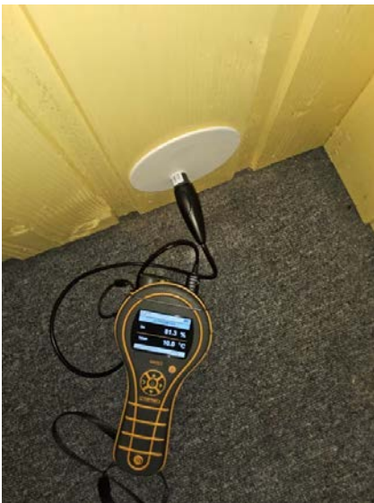
Bilde fra fuktmåling i utlektet veggkonstruksjon.
