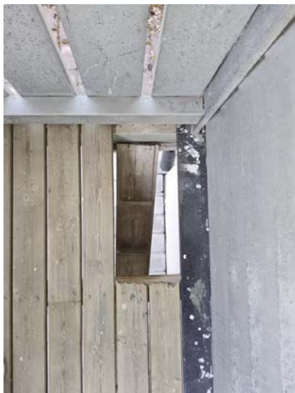
Hull i terrassegulv.
