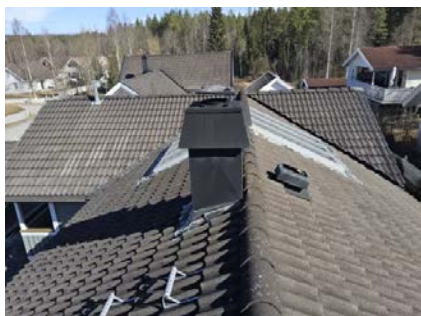
Boligen er oppført med saltak.
