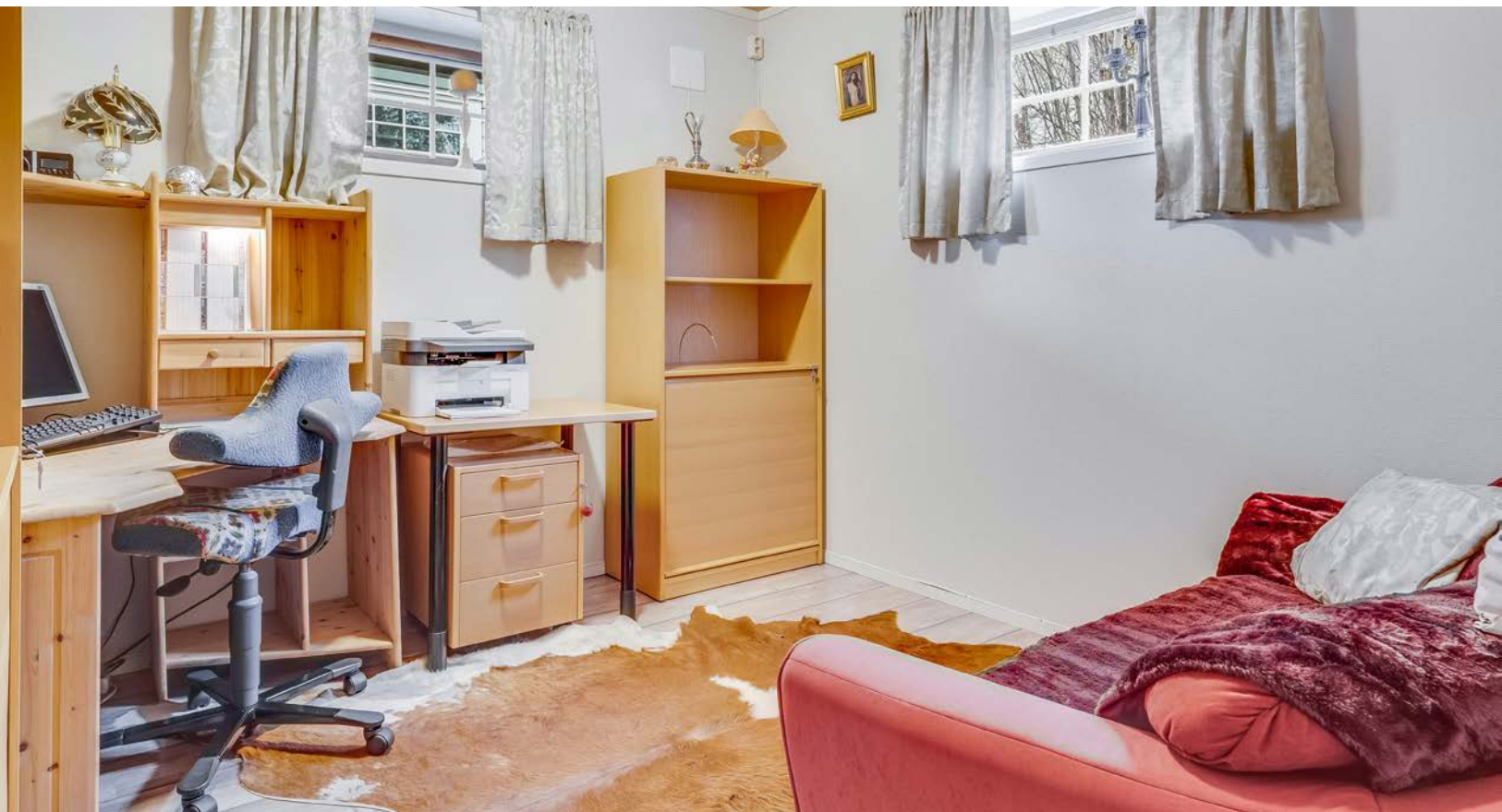
Soverom i underetasjen. Rommet er i følge byggetegninger godkjent som soverom, men vinduet er for lite til at dette er godkjent til varig opphold.
