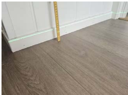
Etasjeskiller er kontrollert med nivelleringslaser.
