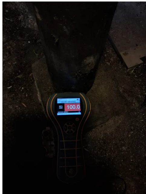
Fuktmåling i bæresøyle.
