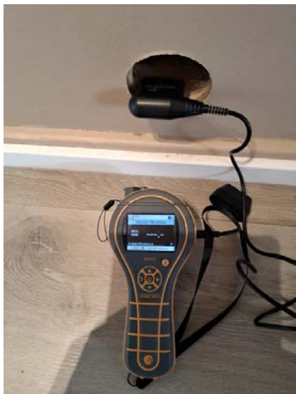
Bilde fra fuktmåling i veggkonstruksjon tilstøtende våtrom.
