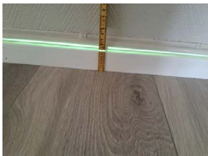
Etasjeskillet er kontrollert med nivelleringslaser.
