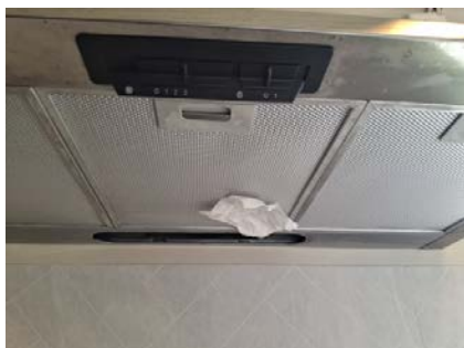
Avtrekkseffekt er testet med papir.
