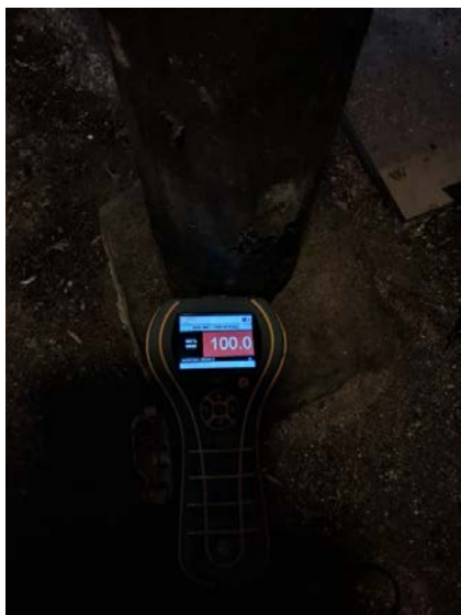
Fuktmåling i bæresøyle.
