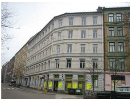
Fasade mot gate
