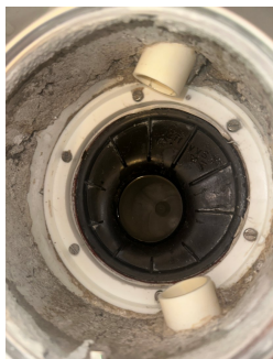
Hovedsluk med klemring for membran
