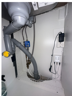
Rørøpplegg i kjøkkenbenk med Waterguard
