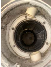
Hovedsluk med klemring for membran
