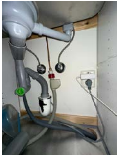
Rørapplegg i kjøkkenbenk med Waterguard
