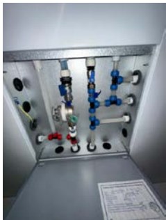
Samleskap med rørkurser og stoppekraner
