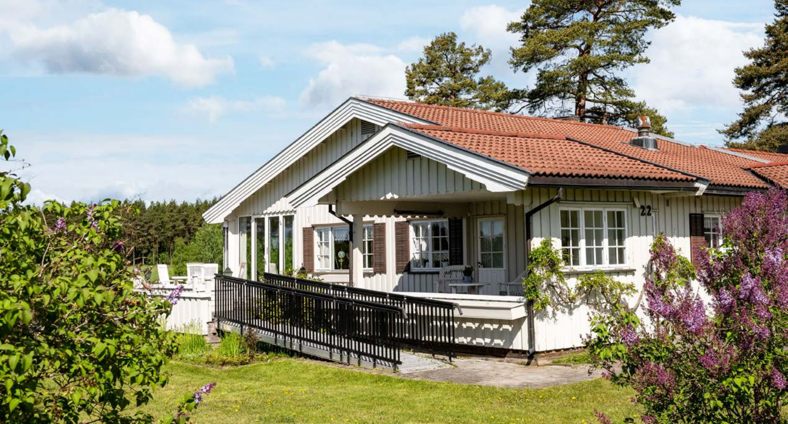
Utvendig rampe til delvis overbygget veranda.
